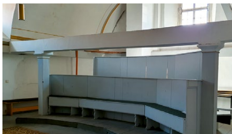
Abbildung 1: St.-Walpurgis-Kirche Apfelstädt, Westempore, einst Singeempore, mit der hinteren Bankreihe der Adjuvanten sowie Stützen und Querbalken der ehemaligen Orgelempore. Foto: Irmela Stock.
